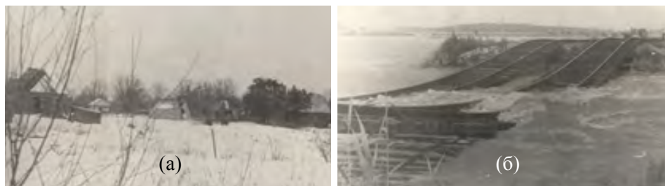
Рис. 8.2.1. Последствия стихийного бедствия: (а) – разрушенные дачные домики на правой пойме р. Малиновки перед мостовым переходом; (б) – разрушение малого моста и железнодорожного полотна Транссибирской магистрали во время паводка
