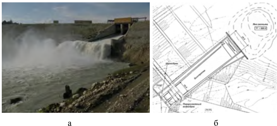
Рис. 6.2.1. Вид на водосброс Кашхатау ГЭС со стороны нижнего бьефа (а) и план эксплуатационного водосброса (б)
